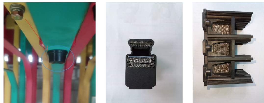
图28 低压柜分支母线绝缘防护方案
