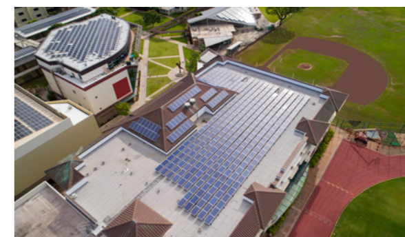
某地复杂屋顶示例
