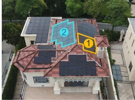
上图为某别墅组件排布设计图，其中左图屋顶建筑区域 1 和区域 2 产生阴影遮挡，为了避免因为木桶效应影响整体发电量，传统方案中会避免在阴影区域安装组件。此外，由于逆变器两路 MPPT，按要求只能安装两个朝向。
