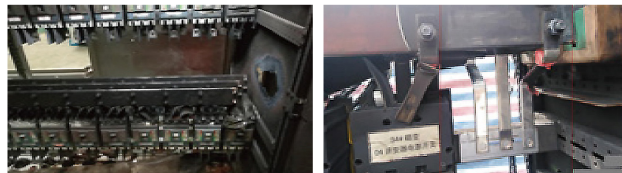
› 箱变喷弧引发的安全事故
