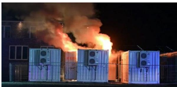
Figura 3 Dois bombeiros feridos pela explosão da porta de sistemas de armazenamento de energia na área comercial de Nemours, Alemanha<sup>5</sup>
