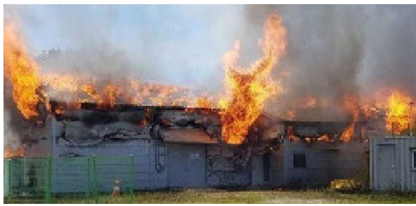
图6.韩国忠南光伏太阳能电站 储能项目火灾现场 12
