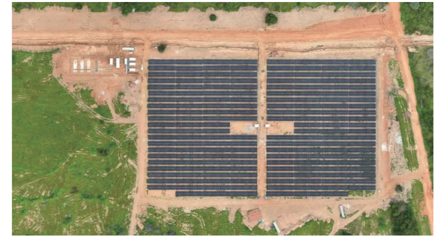
图 3-3：马诺诺 5.1MWp 光伏 + 2.5MW/5MWh 储能锂矿微电网项目
