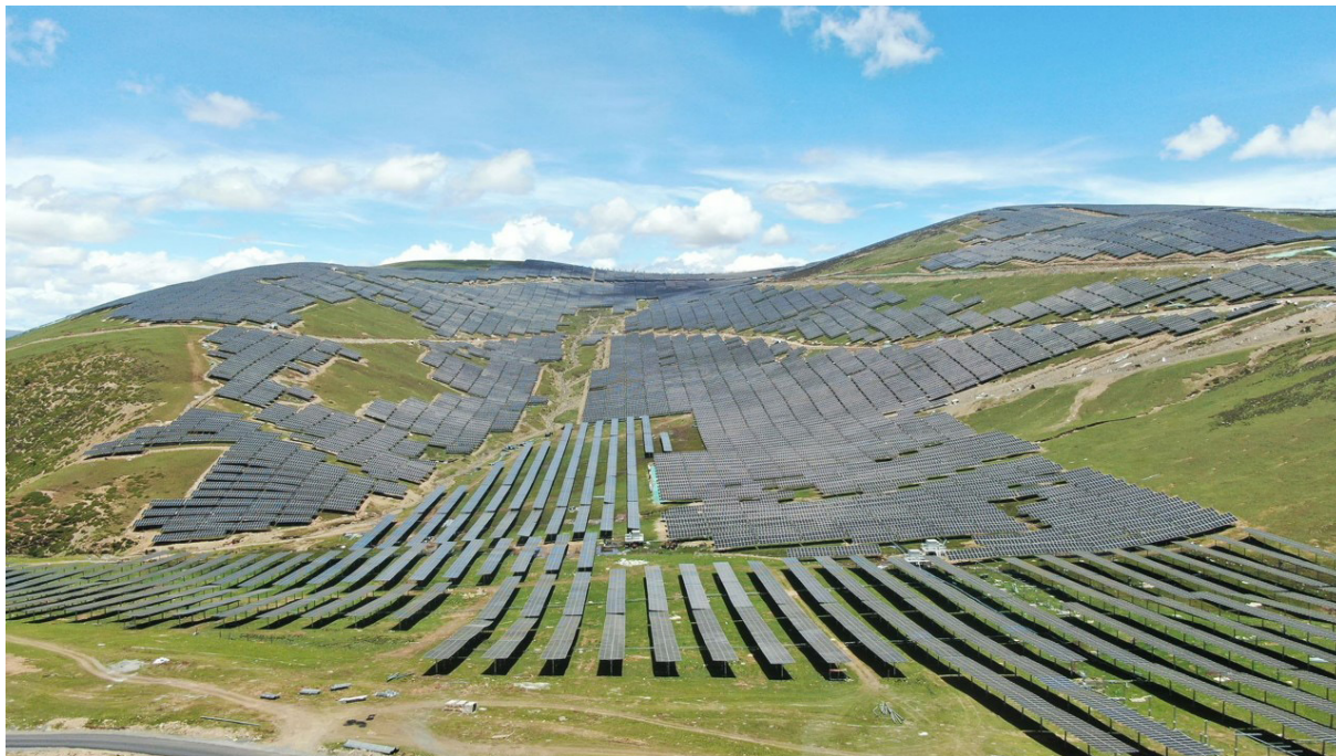
› 某水光互补电站
