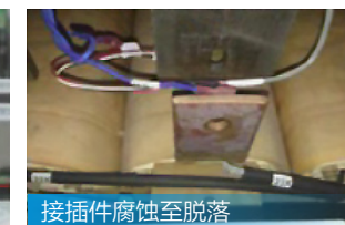
配电柜腐蚀
