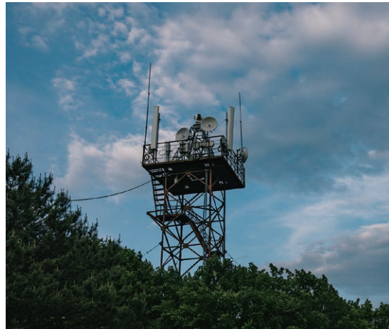
东北虎豹国家公园的 LTE 基站，利旧原有的防火塔，最大限度减少对自然的影响
