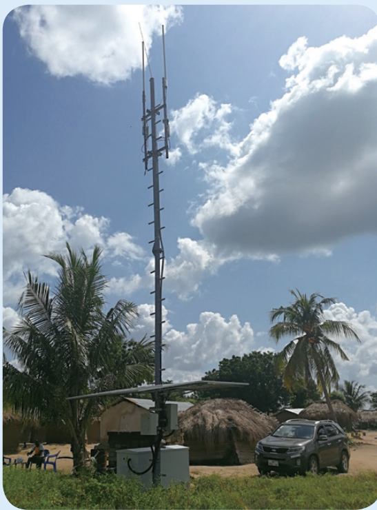
使用太阳能供电的加纳农网
